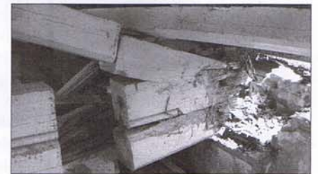
Bedrohlich: Schwammschäden
