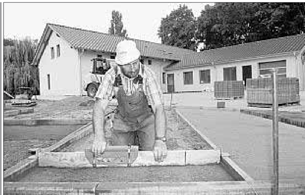
Das neue Zuhause des Fehrbelliner Wasser-/Abwasser-Zweckverbandes in Fehrbellin ist fertig. Nur an den Außenanlagen wird noch letzte Hand angelegt. FOTOS (2): PETER GEISLER
