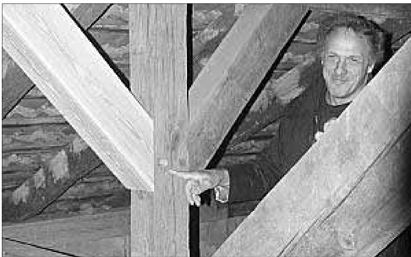
Siegfried Ismer war ständiger Berater der Bauherren. Die Dachstuhlansanierung konnte im Juni abgeschlossen werden. Am Mittwochmittag erklärte der Bauingenieur bei einer Ortsbegehung noch einmal die angewandten Verbindungsarten. FOTO: CORNELIA FELSCH
