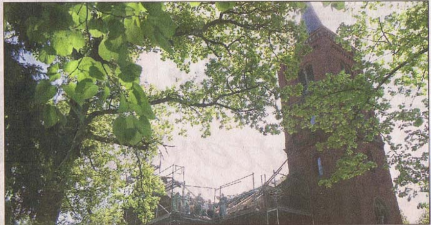
Fachsimplen über Hausschwamm, Mauerwerk und Gebälk in luftiger Höhe. Fotos (3): Kreuzer
