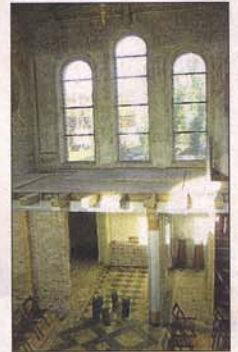
Die Nordempore soll in diesem Jahr saniert werden.
