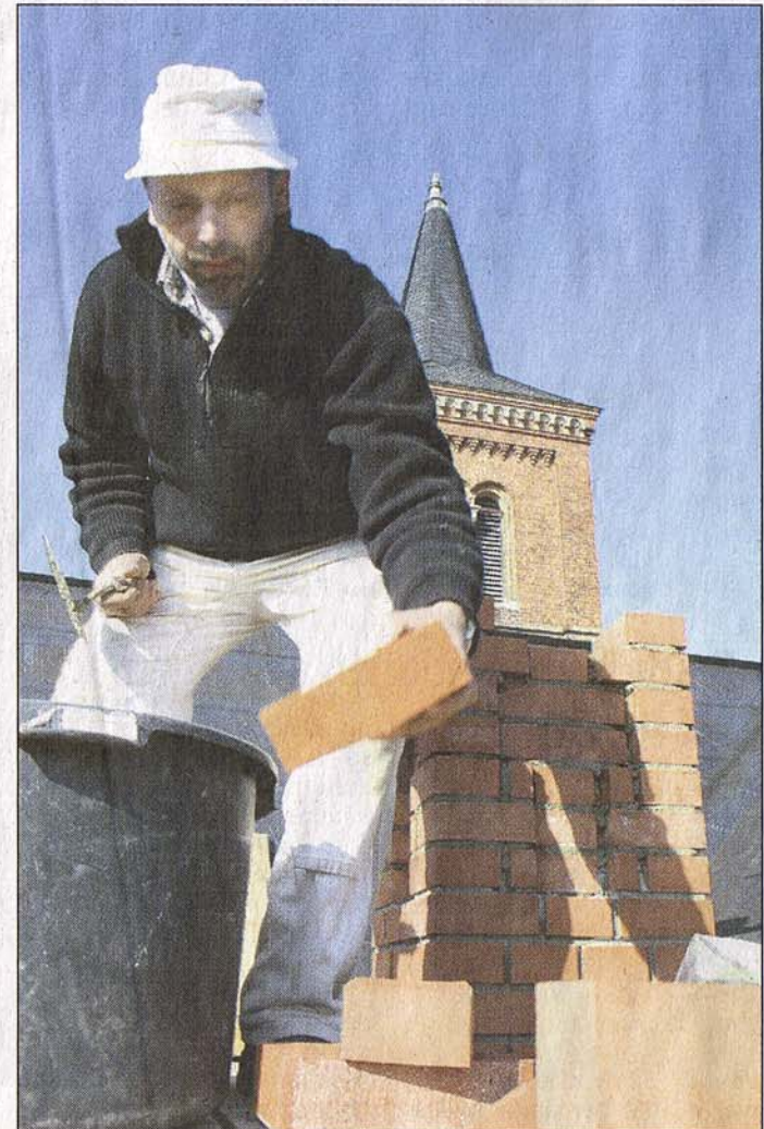
Die Prenzlauer Denkmalpflege GmbH erneuert in Vichel derzeit die Schornsteine der Kirche. Fotos (2): Kluge
