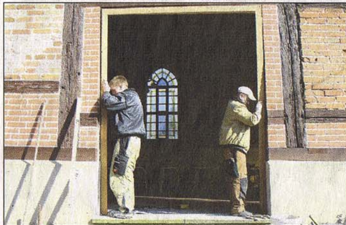
Die Fehrbelliner Tischlerei Flemming und Söhne baute gestern in Lüchfeld eine neue Kirchentür ein.
