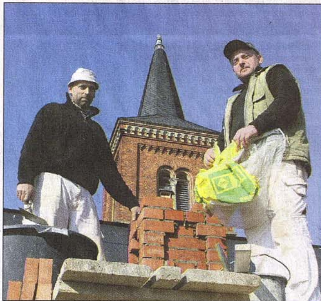
Die Mitarbeiter der Denkmalpflege GmbH Prenzlau arbeiten derzeit in Vichel an den Schornsteinen der Kirche. Demnächst sind das Dach und die Läutanlage dran. Foto: Kluge
